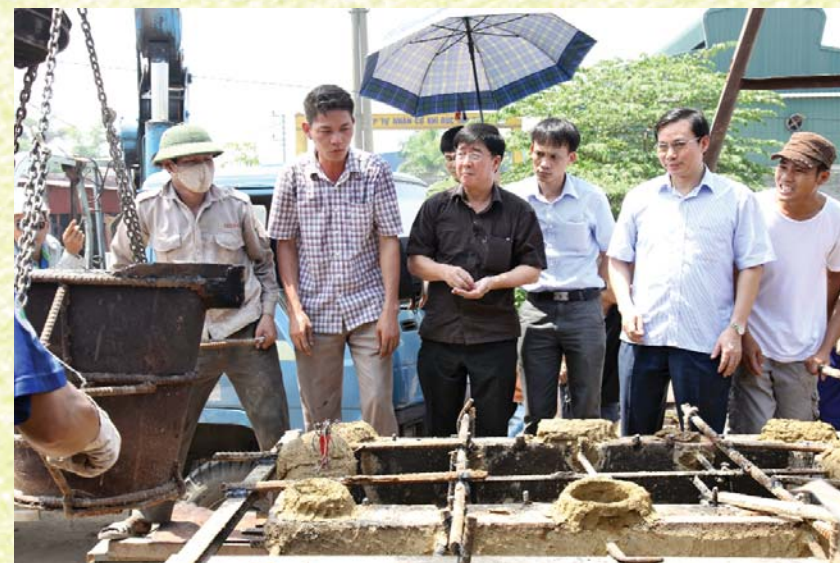
Đồng chí Nguyễn Hồng Hà, Tổng Giám đốc Kho bạc Nhà nước kiểm tra công trình thi công Lư hương đồng đặt tại Nghĩa trang Liệt sỹ Quốc gia Đường 9 do Kho bạc Nhà nước cung tiến.
